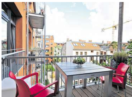
Den vorgeständerten Balkon, der erst bei der Sanierung hinzu kam, genießt das Paar sehr – auch im Winter. Er misst 3,30 mal 1,50 Meter
